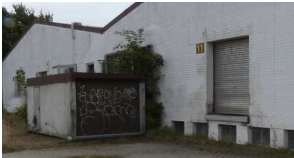
Abb. 10: Fertigteilgarage vor nordwestlicher Hallenschmalseite (Quelle: H & P)
