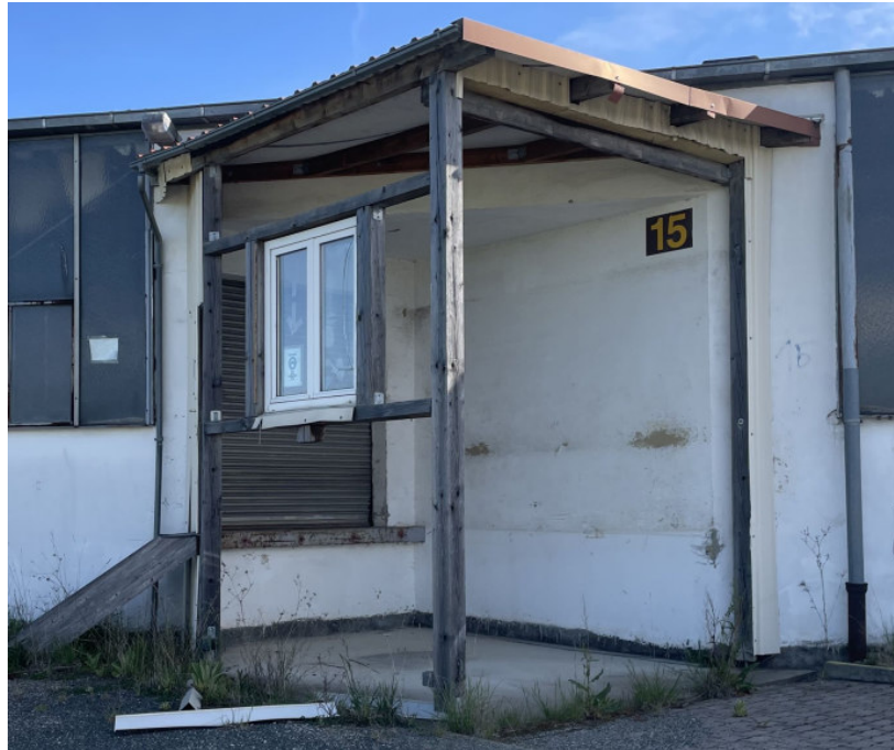
Abb. 18: Offener Anbau an der südlichen Hallenlängsfassade (Quelle: H & P)
