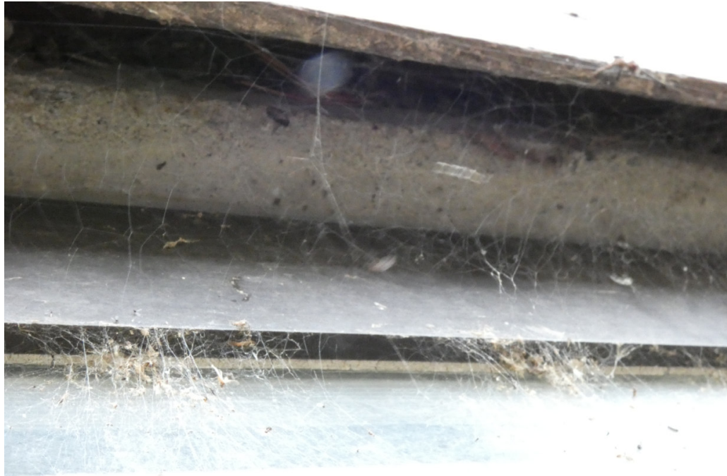
Abb. 15: Potenzielles Spaltenquartier entlang des Dachrandes Bürotrakt (Quelle: H & P)
