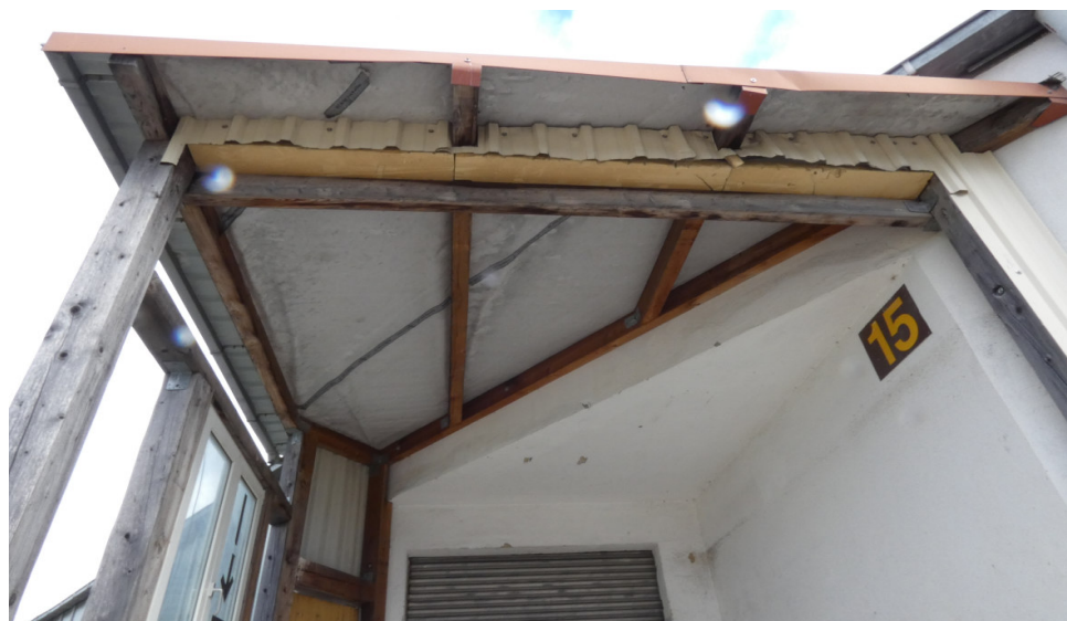
Abb. 19: Untersicht Dachkonstruktion Anbau südliche Hallenlängsfassade (Quelle: H & P)
