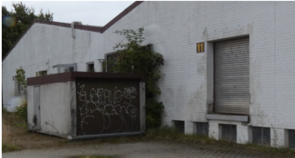
Abb. 10: Fertigteilgarage vor nordwestlicher Hallenschmalseite (Quelle: H & P)
