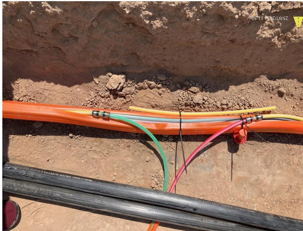
**Rotes Röhrchen:** Führt direkt **zum Netzverteiler** und enthält später die **Glasfaser**
