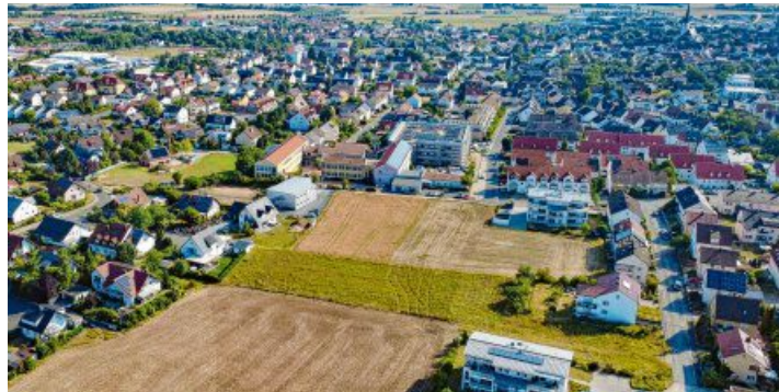
Angrenzend an die Realschule: Auf Freiflächen in Richtung Unterzettlitz soll das allgemeine Wohngebiet „St.-Veit-Straße“ entstehen. Unter den Nachbarn aber regt sich kräftiger Widerstand. Foto: Markus Drossel
