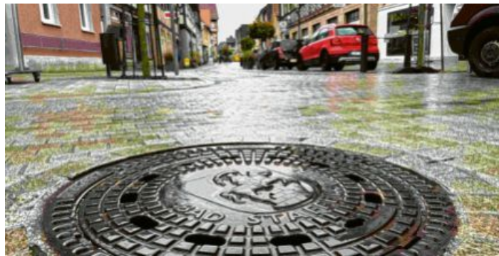
Nach und nach wird das 160 Kilometer lange Kanalnetz in Bad Staffelstein und den Dörfern befahren. Nur so kann der Gesamtzustand professionell erfasst werden. Foto: Markus Drossel
