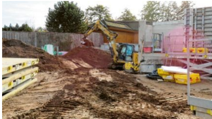
Die Bagger rollen auf der Baustelle nahe der Obermain Therme in Bad Staffelstein. Fotos: Monika Schütz
