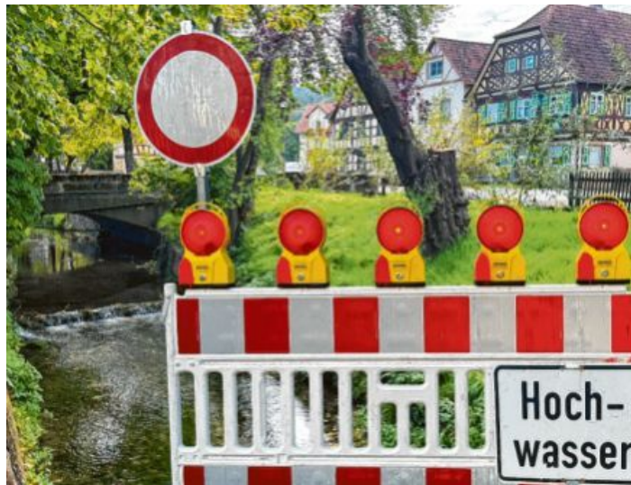
Nach einem längeren Landregen könnte die Lauter derart anschwellen, dass sie über die Ufer tritt. Bei einem hundertjährigen Hochwasser wären bis zu 1000 Anwesen akut gefährdet. Foto: Markus Drossel
